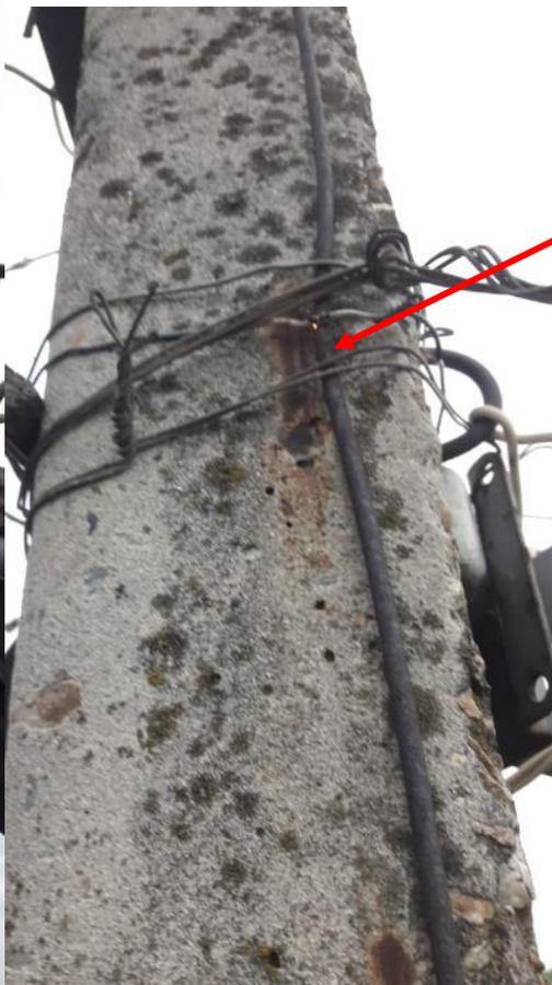
Фотография №6. Следы перекрытия на заземляющем спуске.
