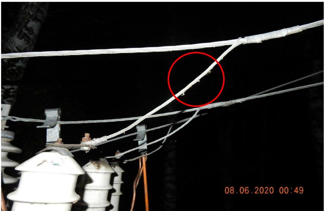
Фотография № 5. Следы воздействия электрической дуги на проводе.
