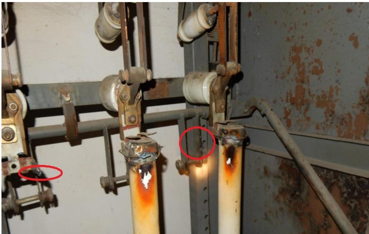
Фотография №4. Следы короткого замыкания в ячейке РУ 10 кВ.
