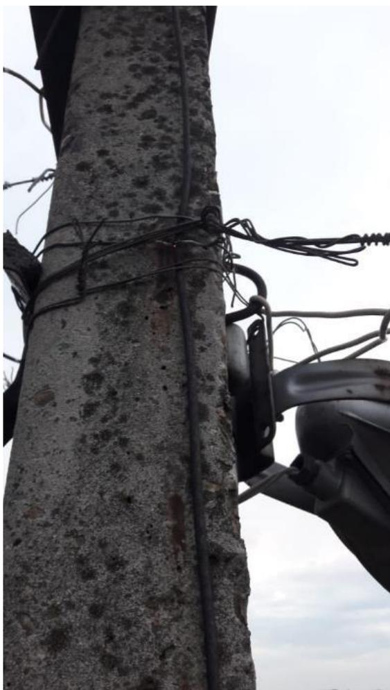
Фотография № 5. Провод питания светильника со следами перекрытия
