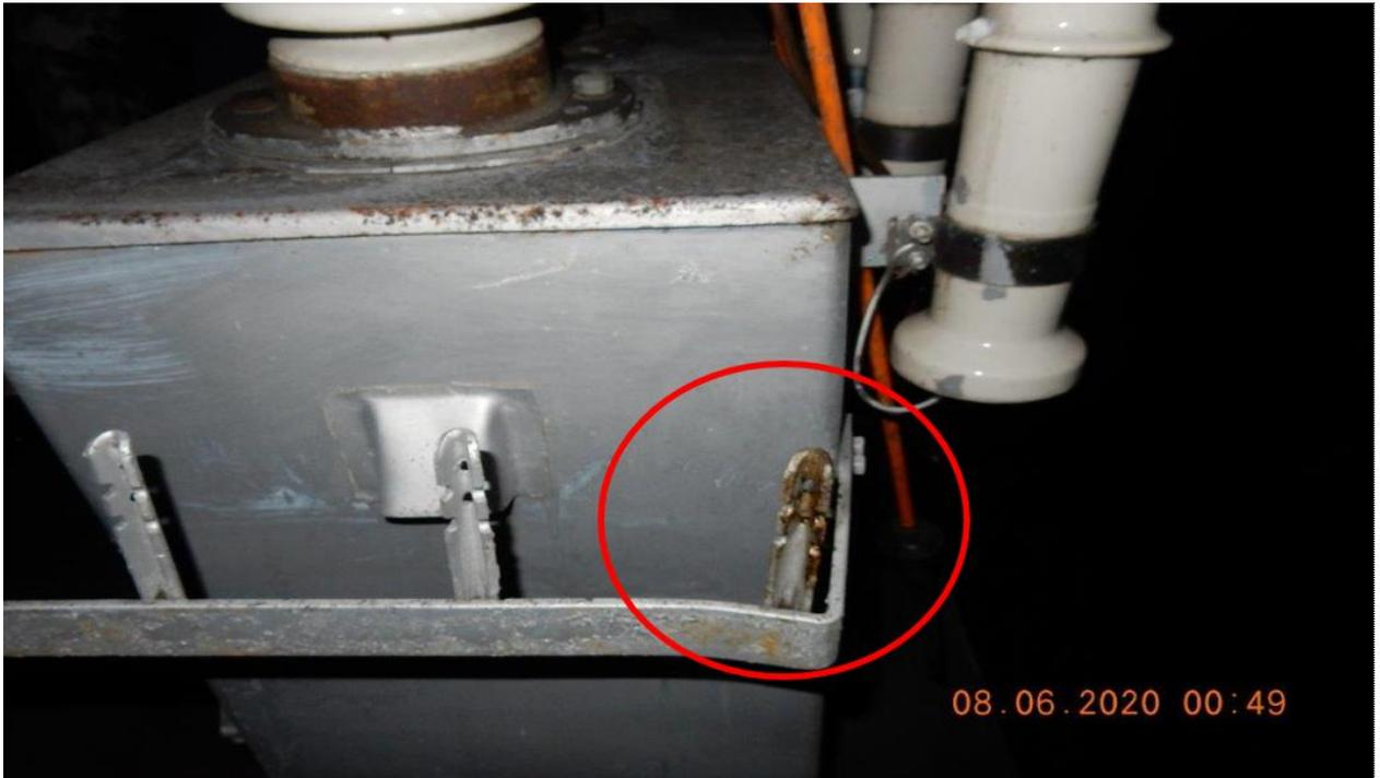
Фотография № 4. Следы воздействия электрической дуги на траверсе.
