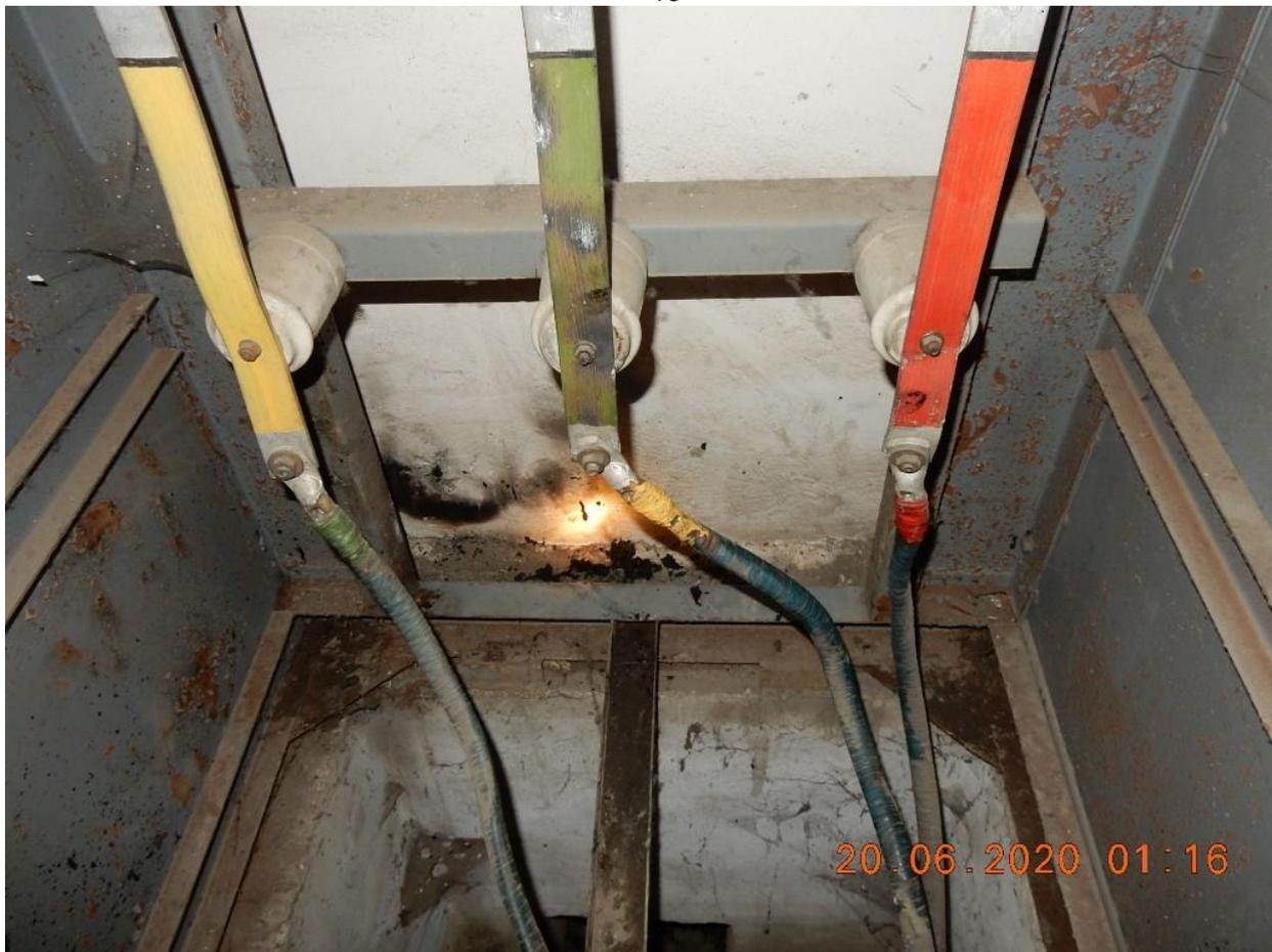
Фотография №5. Следы воздействия электрической дуги и остатки горелой одежды в ячейке РУ 10 кВ.
