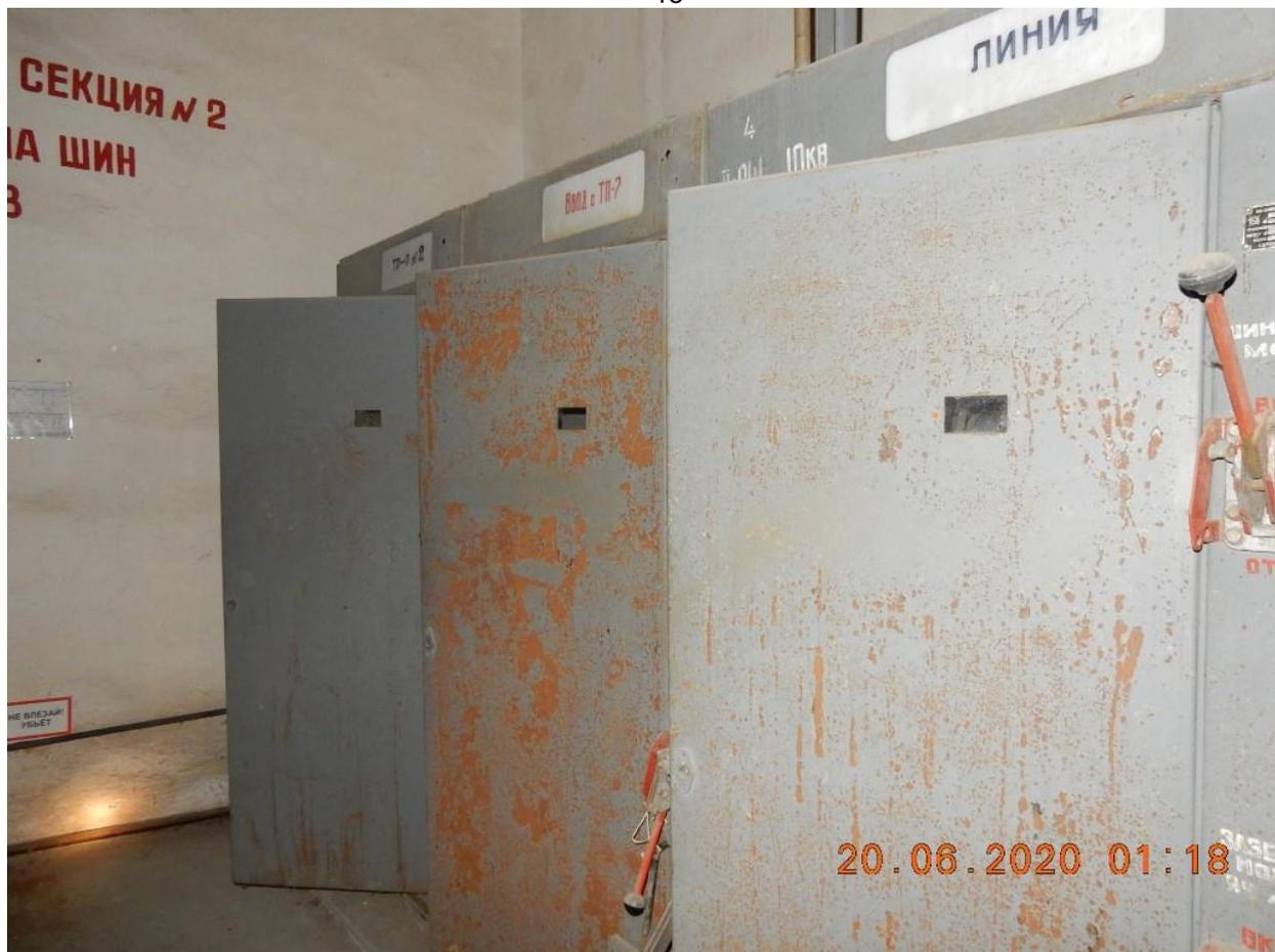
Фотография №3. Ячейки 2-й секции ТП. Двери ячеек открыты.
